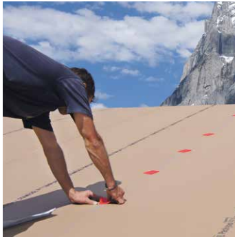
Anbringen der Schraubendichtungen direkt auf der Unterdachbahn.
