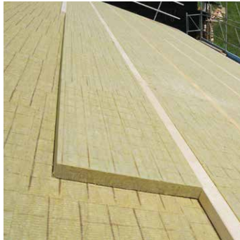
Zweischichtiger Dachaufbau bis 300 mm Dämmdicke.
