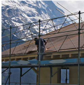
Montage der Unterdachbahn.
