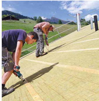
Trittfest durch spezielle Wellfaserstruktur.
