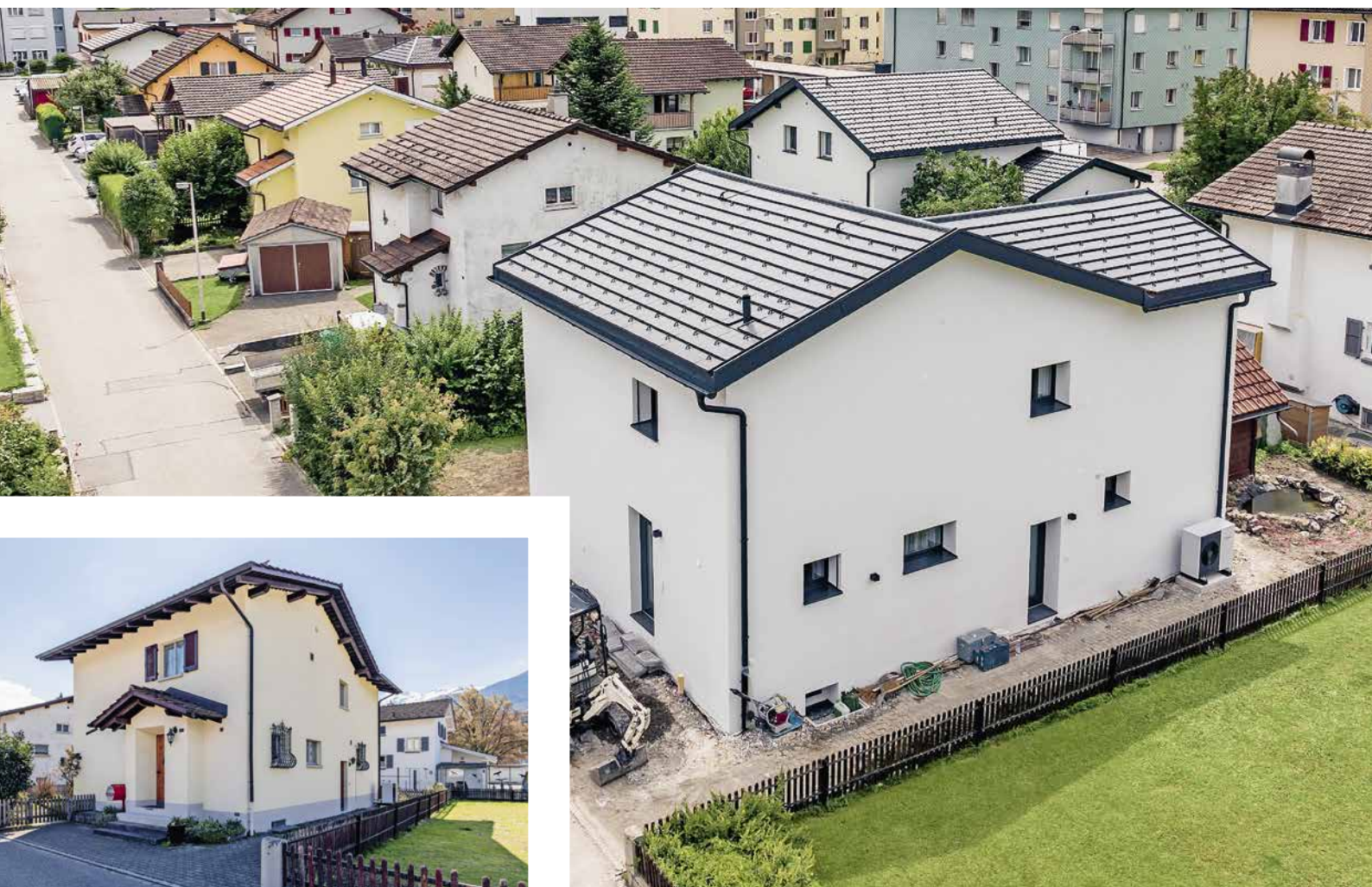
Eingangssituation vor und nach der Sanierung.
