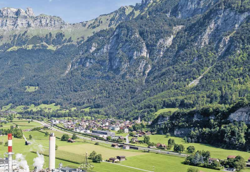
Sommer 2023: Das neue Ofenhaus steht, die Filteranlage ist bereit. Bis April 2024 wird nun der neue Elektroschmelzofen montiert und an die Produktionslinien angeschlossen.
