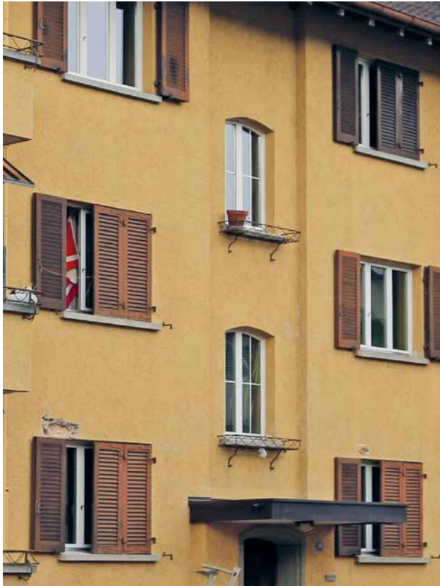
Vorher: Unsaniertes Gebäude
