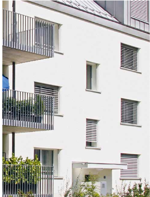
Nachher: Saniert mit Fassadensystem POLYROC
