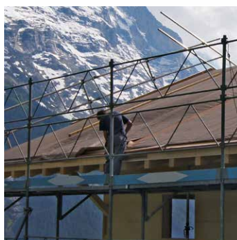
Pose de la sous-couverture.
