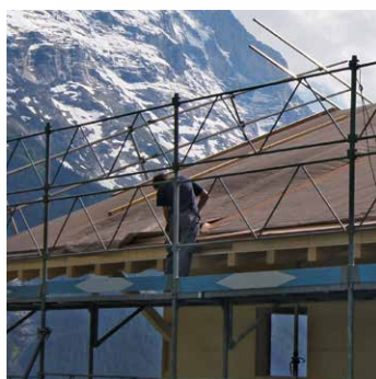
Montaggio della guaina per sottotetto.
