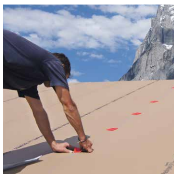
Applicazione delle guarnizioni per viti direttamente sul sottotetto.
