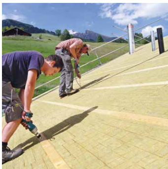
Calpestabile grazie alla speciale struttura a fibre ondulate.
