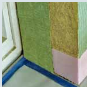
Le panneau isolant COMPACT en laine de pierre convient pour tous les surfaces planes, cintrées ou obliques... pour un montage simple, rapide et avantageux.
