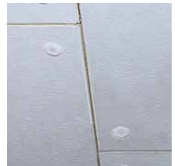
Spezialdübeln durch Bohrmontage.
