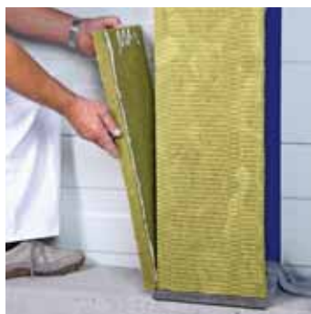
5 Applicazione del rivestimento antincendio sulla flangia laterale
