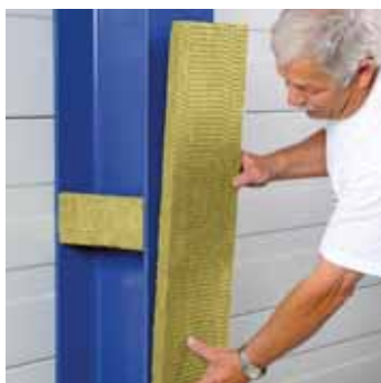
4 Applicazione del rivestimento antincendio sul davanti
