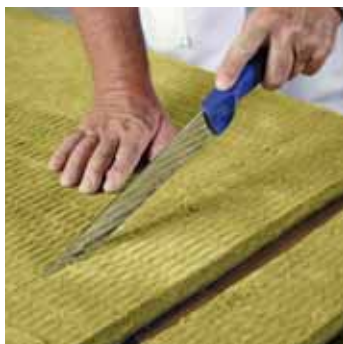
1 Taglio su misura dei pannelli
