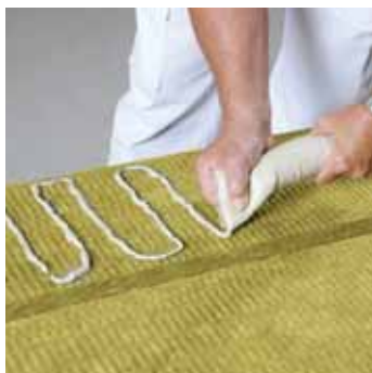
3 Applicazione di Conlit® Fix sul rivestimento (con un cordone adesivo)
