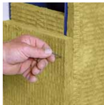
6 Fissaggio del rivestimento antincendio con perni metallici finché si è seccato l'adesivo (fino a 12 ore).
