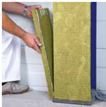
5 Pose du revêtement anti-feu sur les faces latérales
