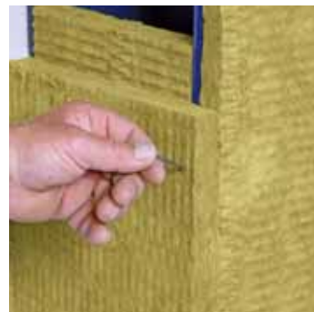
6 Fixation du revêtement anti-feu au moyen d'agrafes en acier en attendant le séchage de la colle (jusqu'à 12 heures)
