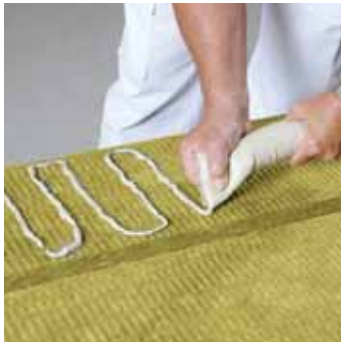
3 Application de la colle Conlit® sur le revêtement (en serpentins)
