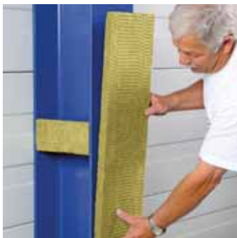
4 Pose du revêtement anti-feu contre l'aile
