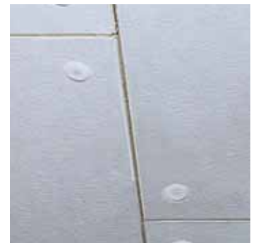
Montage avec tampons spéciaux et perceuse.
