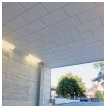
Exemple: entrée d'un garage souterrain
