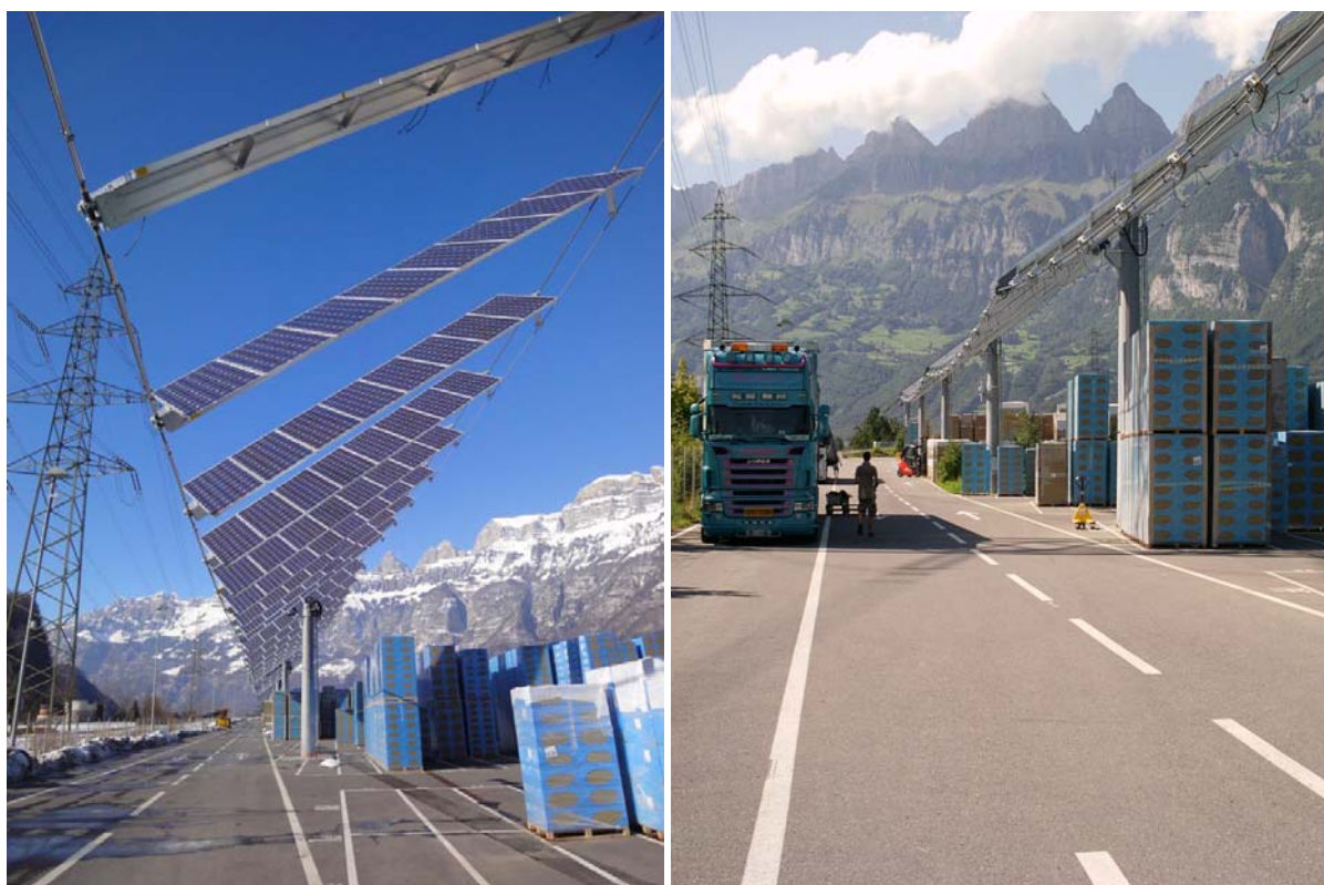
Abbildung 1 Blick auf die zweiachsige Solar Wings Nachführung der Flumroc AG, die über dem Aussenlager der Flumroc in Flums Anfang 2010 realisiert wurde. Die Zwischenstützen haben einen Abstand von 35m und je 10 Modulträger sind im Abstand von 3.2m auf den Tragseilen zwischen zwei solcher Zwischenstützen montiert.
