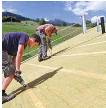
Trittfest durch spezielle Wellfaserstruktur.
