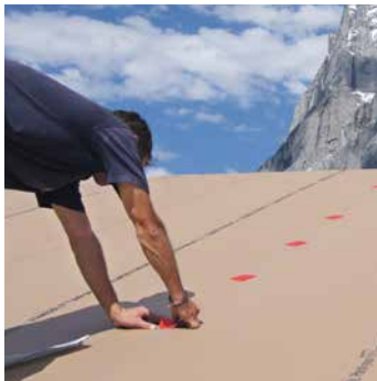
Anbringen der Schraubendichtungen direkt auf der Unterdachbahn.
