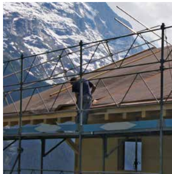
Montage der Unterdachbahn.
