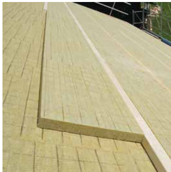
Zweischichtiger Dachaufbau bis 300 mm Dämmdicke.
