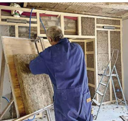
Die Dämmplatten konnten vor Ort einfach angepasst werden.
