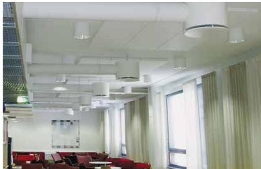
Homogene Dämmplatte mit Sichtoberfläche aus weissem Glasvlies. Kanten umlaufend gefast und mit deckend weisser Farbe beschichtet. Für Keller-, Hallen- und Tiefgaragendecken sowie für Innenräume mit akustischen Anforderungen.
