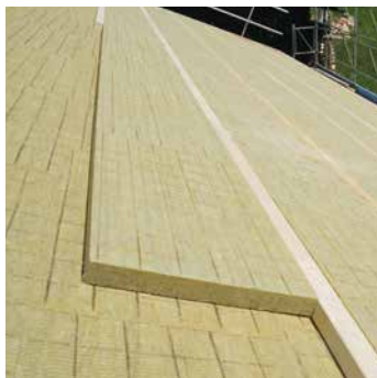
Construction deux couches jusqu'à 300 mm d'épaisseur d'isolation.
