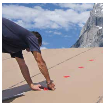
Pose des taquets d'étanchéité directement sur la sous-couverture.
