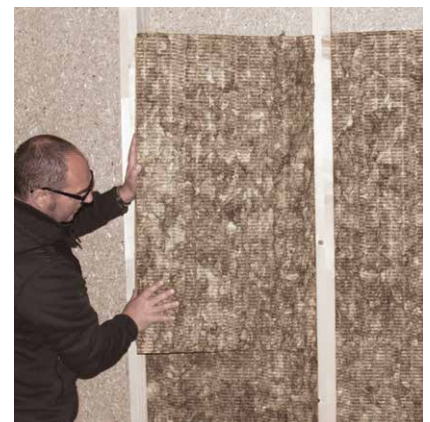
Construction en ossature bois
