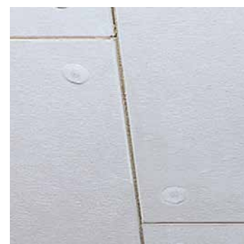
Montage avec tampons spéciaux et perceuse.
