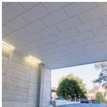
Exemple: entrée d'un garage souterrain.
