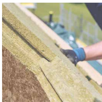
Connessione con giunto maschio e femmina
