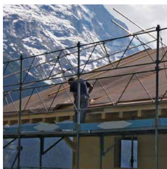
Montaggio della guaina per sottotetto.
