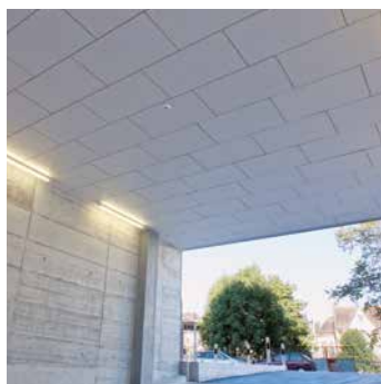
Esempio di accesso a un'autorimessa sotterranea.
