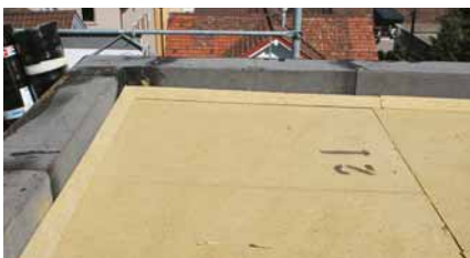
Dachrandkeile bei Aufbordungen im Flachdach.
