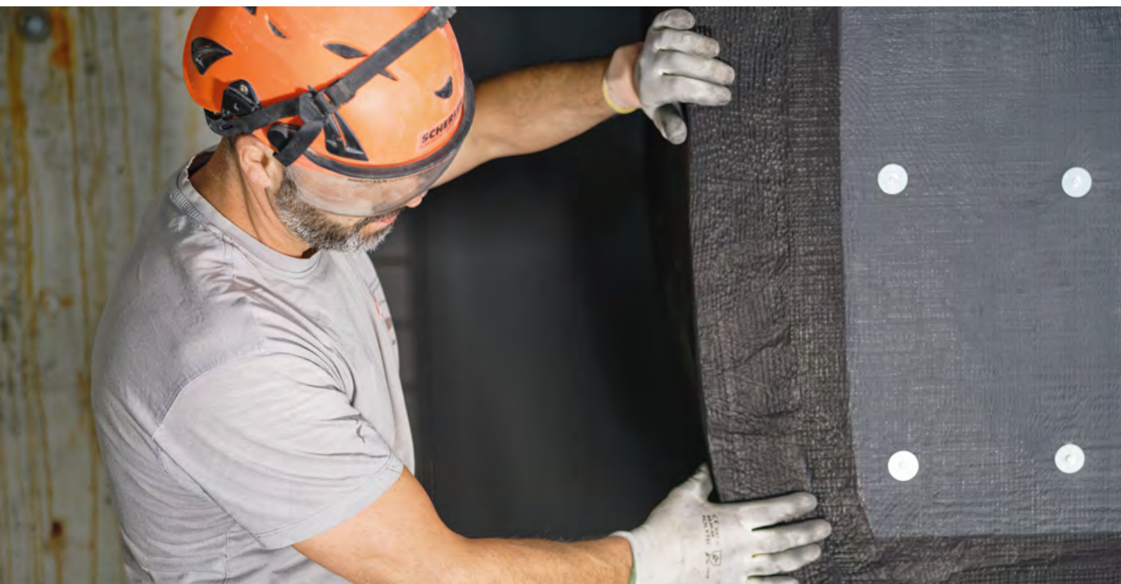
Selon la co-directrice, le maniement des panneaux de protection incendie de Flumroc est agréable pour le personnel d'ACI AG.
