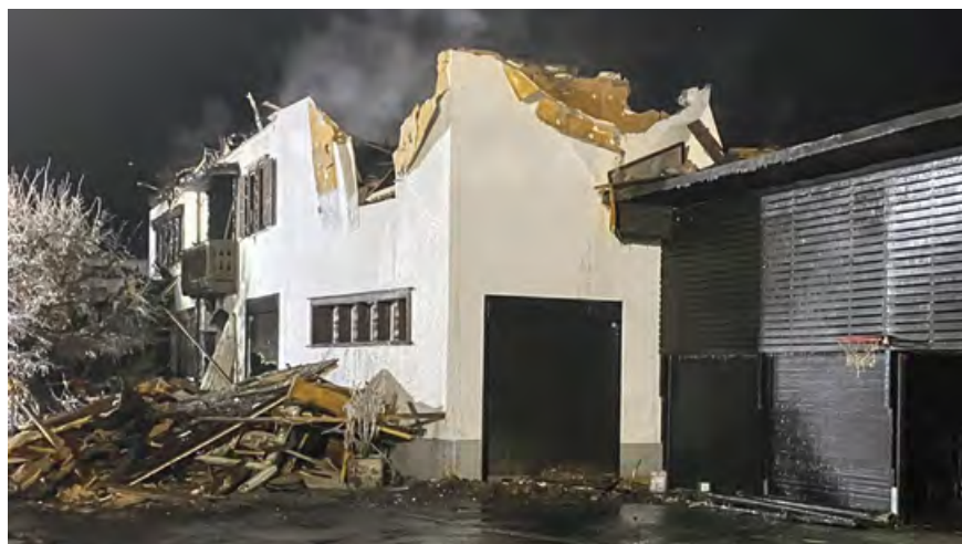
Soltanto il pianterreno aveva resistito all'incendio del 2022 perché una ventina di anni prima era stato ristrutturato usando come isolante della lana di roccia Flumroc.
