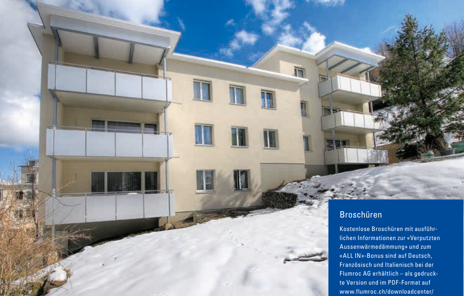
Wohnbaugenossenschaft Gess: Flumroc-Steinwolle machte Brandriegel überflüssig.
