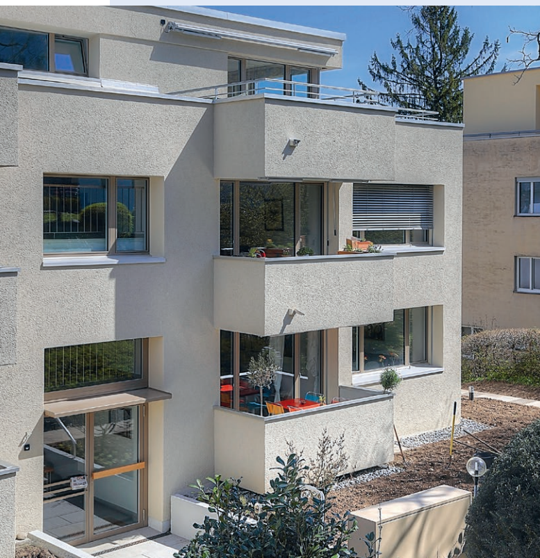
L'entrée flambant neuve.
