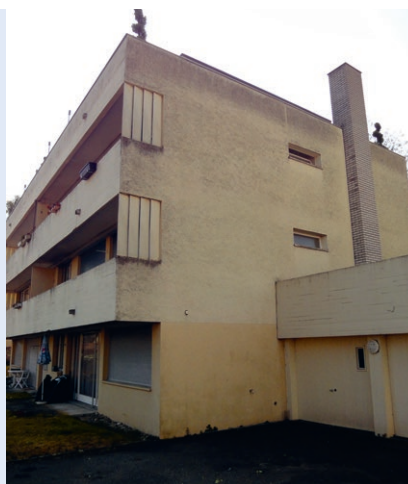
La façade avant l'assainissement...
