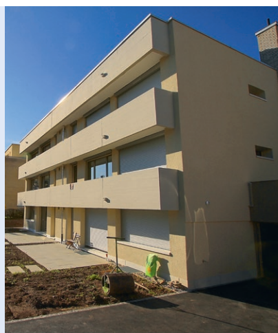
... et après les travaux.
