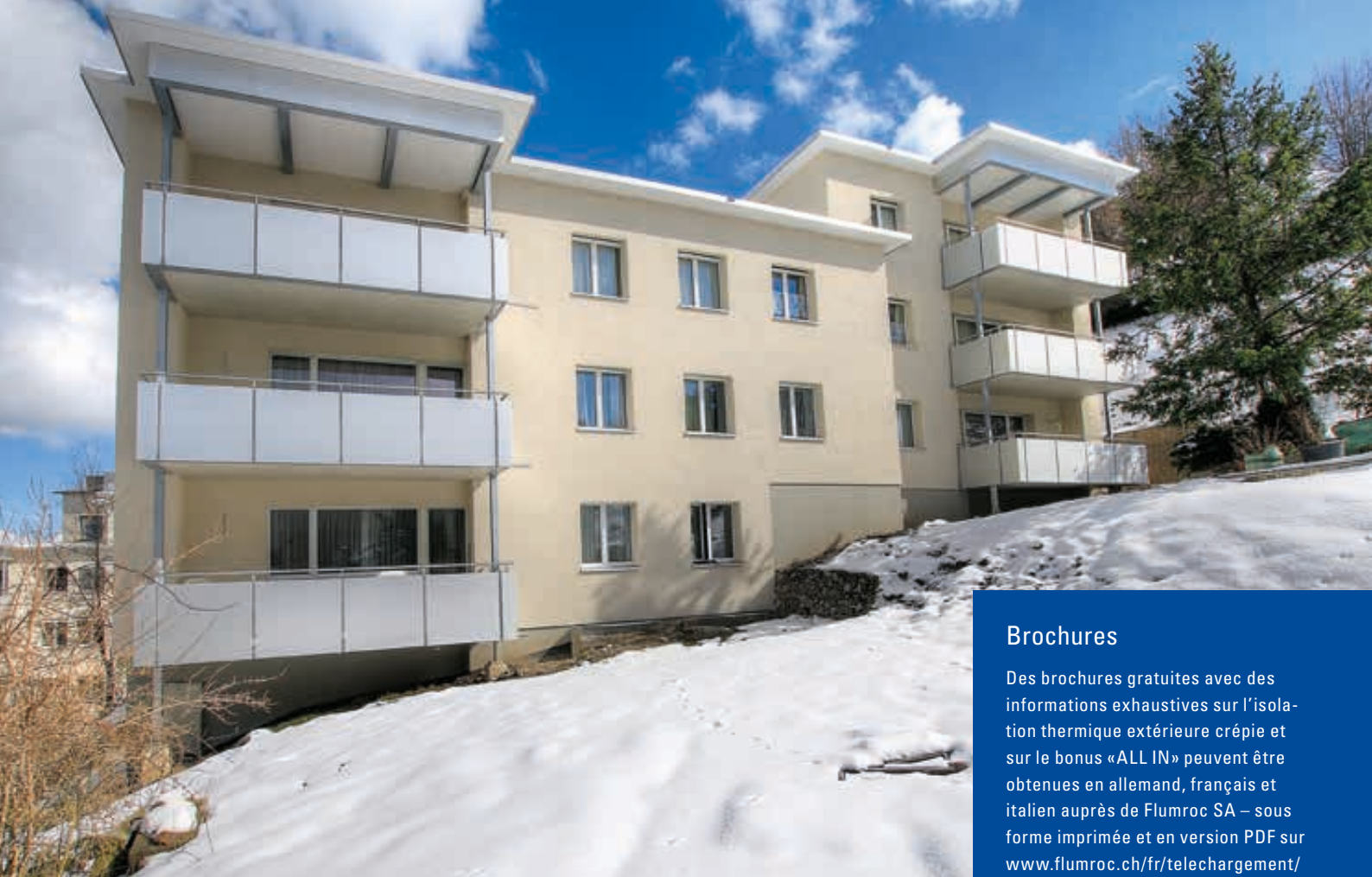
Coopérative d'habitation Gess: la laine de pierre Flumroc rend inutile les pare-feu.
