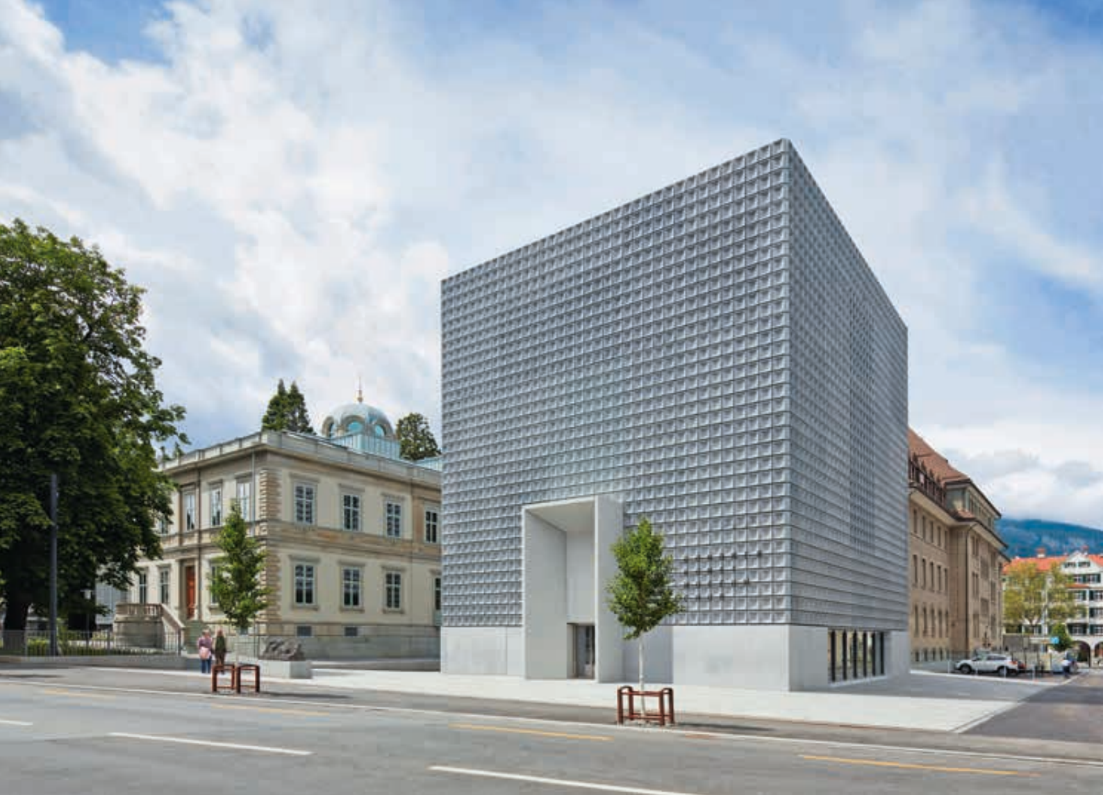
Edificio di ampliamento del Museo d'arte a Coira: la facciata ventilata con un bassorilievo in elementi presagomati in calcestruzzo. Foto: Ralph Feiner
