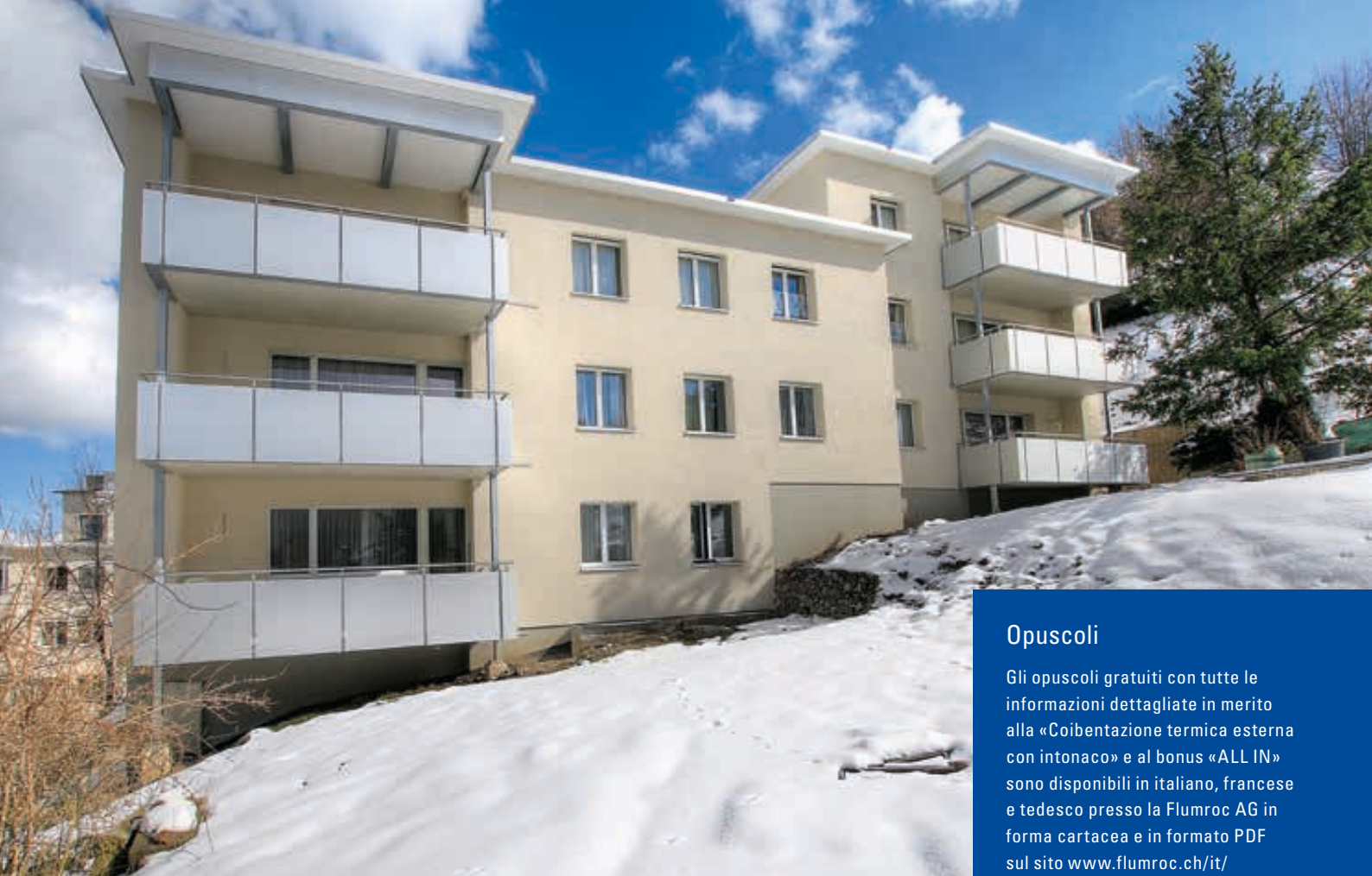
Cooperativa edile Gess: la lana di roccia ha reso superflue le traverse antincendio.
