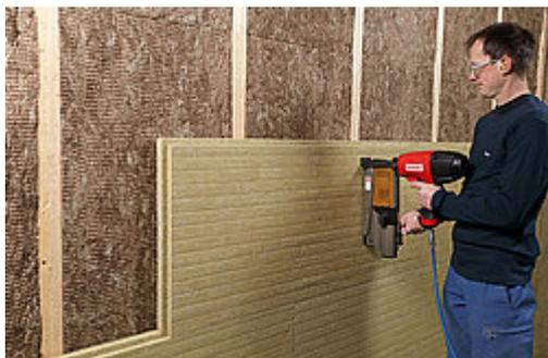
Druckfeste, nicht brennbare Dämmplatte, allseitig mit Nut und Kamm. Vollflächige Dämmschutzschicht bei hinterlüfteten Fassaden, direkt in den Holzständer geklammert.
