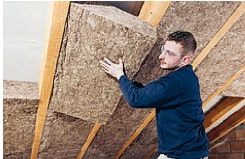
Elastische Dämmplatte in verschiedenen Breiten mit spezieller Knautschzone entlang der Längsseite. Einbau im konstruktiven Holzbau mit Zwischenmassen von 460 bis 700 mm.
