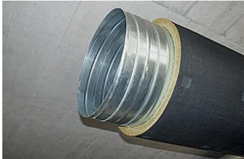
Einlagige Brandschutzbekleidung EI 30 und EI 60 für Lüftungsrohre aus verzinktem Stahlblech. Geprüft nach der neusten Prüfnorm EN 1366-1:2014 inklusive Einbau durch leichte Trennwände.
