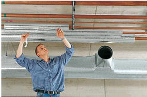
Konzentrisch gewickelte, alubeschichtete Rohrschale. Einseitig aufgeschlitzt und auf der Innenwandung eingesägt. Für Heizungs- und Warmwasserrohrleitungen mit Betriebstemperaturen bis 250 °C.
