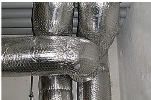
Matelas isolants avec revêtement aluminium pour une application à des températures élevées.
