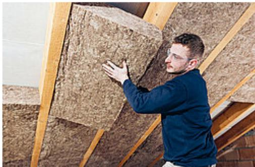
Panneau isolant élastique de différentes largeurs avec zone déformable spéciale du côté longitudinal. Utilisation dans la construction bois avec des écartements entre 460 et 700 mm.
