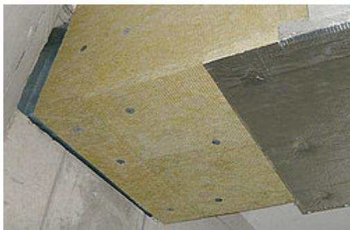
Pannello isolante indeformabile e resistente alla compressione per applicazioni ad alte temperature.
