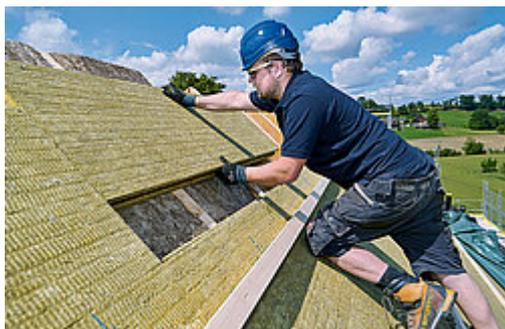
Pannello di grande formato resistente alla compressione, con giunto maschio e femmina su tutti i lati. Strato isolante su tutta la superficie per tetti spioventi e pareti.
