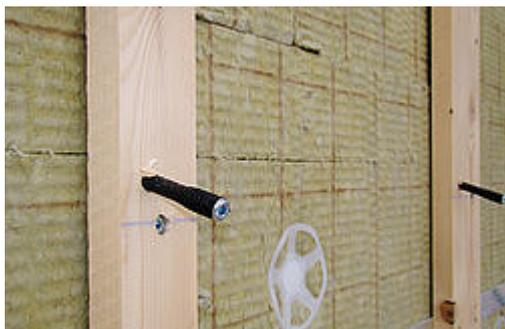
Pannello isolante a due stati con strato interno elastico e strato esterno più duro e intagli tra loro distanziati di 200 mm. Coibentazione sull'intera superficie di facciate ventilate per sistemi di ontaggio con viti distanziali e profilati angolari in alluminio.
