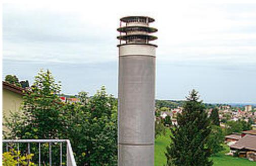
Coppella indeformabile avvolta con fibre a disposizione concentrica, rivestita in alluminio, ad alto valore isolante con un basso spessore isolante. Indicata per le canne fumarie di metallo in conformità delle disposizioni dell'AICAA.
