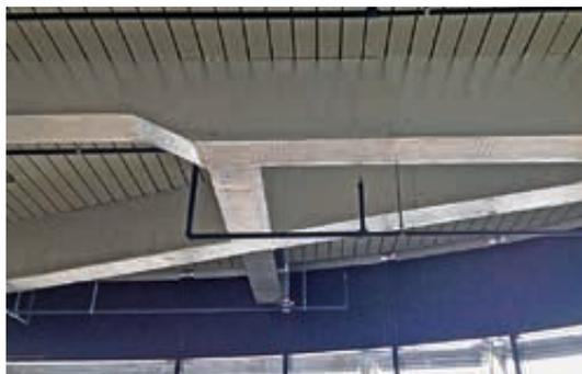
Druckfeste, formstabile Dämmplatte mit einseitiger Alubeschichtung. Brandschutzbekleidung von Stahlunterzügen und Stahlträgern für die Feuerwiderstandsdauer von 30–180 min., resp. bei Stahlstützen von 30–120 min.
