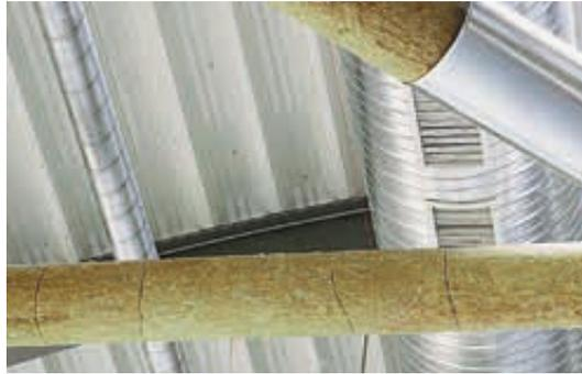
Druckfeste, formstabile Rohrschale. Brandschutzbekleidung von runden Stahlstützen und Windverbänden für die Feuerwiderstandsdauer von 30–120 min. Bekleidung von Feuerlöschleitungen bis 90 min.
