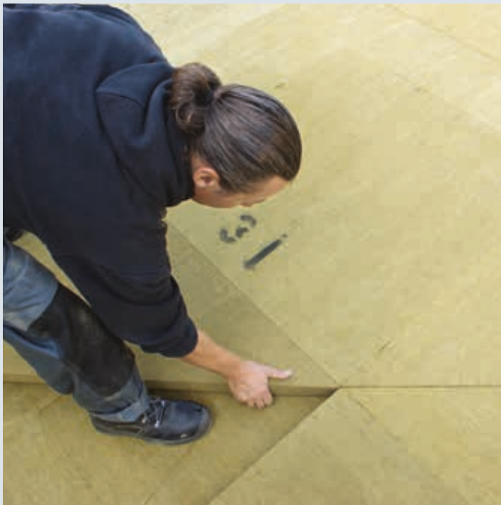
Les panneaux isolants à pente intégrée de différentes épaisseurs sont assemblés pour obtenir une pente régulière du toit. Chaque panneau est clairement marqué.
